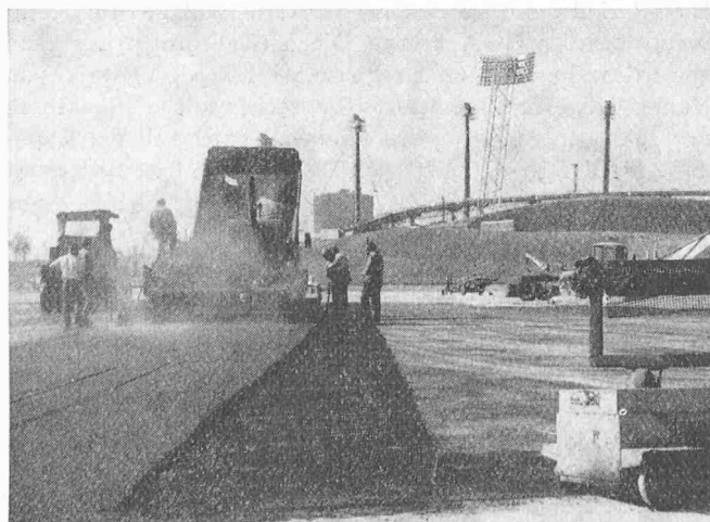
Olympiasee, München. Einbau des Asphaltes mit einem Fertiger über dem verlegten Structofors-Gewebe
