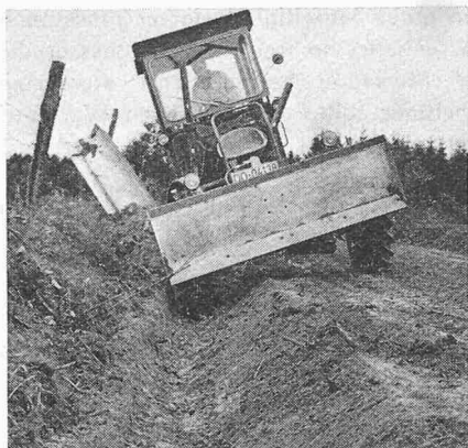
Bild 8. Andecken der Grabenaussenböschung und Fertigprofilierung mit ausgefahrner Schar
