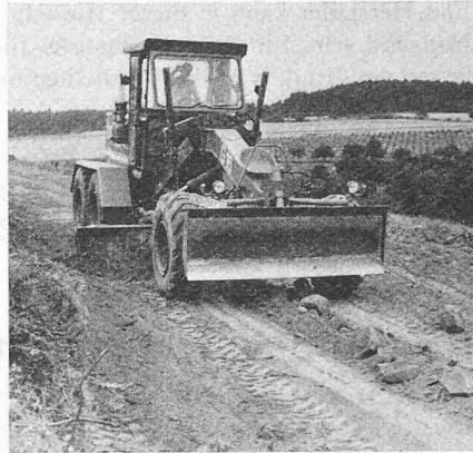
Bild 10. Fertigprofilieren mit der Hauptschar
