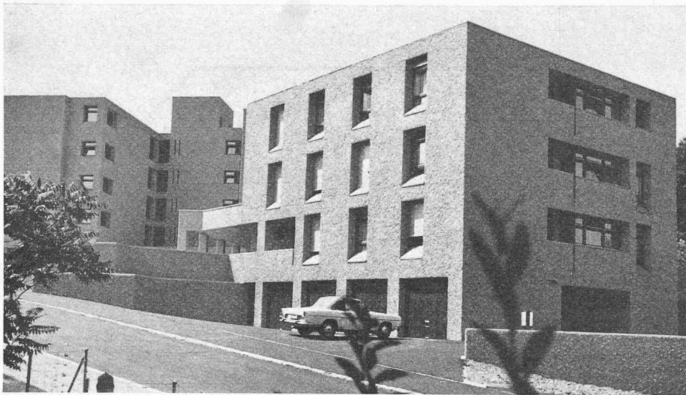
Ansicht aus Norden (Spitzweg). Vorn Personalhaus mit Stützmauer Eingangshof, hinten Wohnheim
