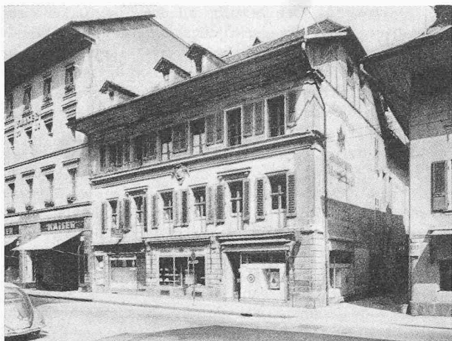
Das Tscharnerhaus an der Amtshausgasse in Bern, 1735
