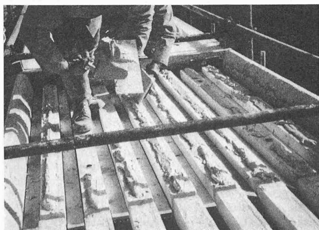
Bild 34. Aufbringen des Epoxyharz-Mörtels zum Kleben des Deckels auf das Zugbandelement. Sichtbar sind drei der vier Hülsen mit Innengewinde, welche den Deckel mittels vier Bolzen festhalten
