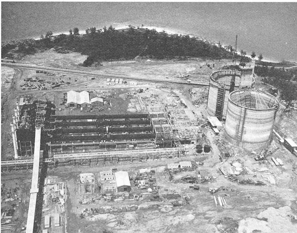
Bild 6. Kalzinieranlage und Tonerdesilos im Bau
