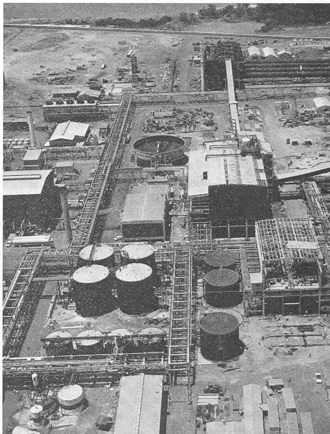
Bild 5. Hydrat- und Sicherheitsfiltrationsgebäude
