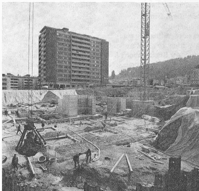
Die Baustelle Ende Mai 1971. Fundationsarbeiten im 2. UG und aufgehendes Betonmauerwerk der Installationskerne
