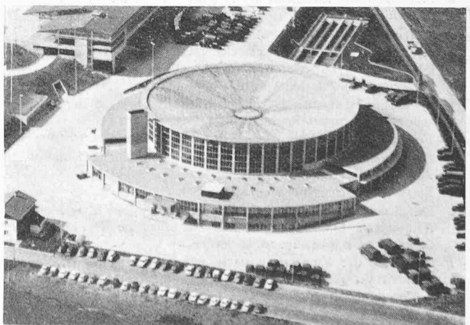
Bild 2. Flugaufnahme der Rundhalle mit Annexbauten
