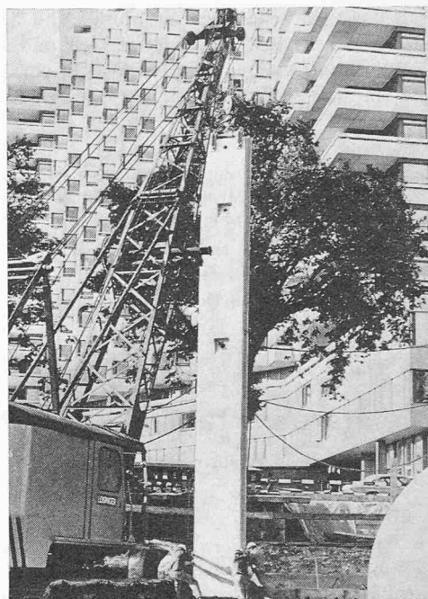
Bild 5. Versetzen eines Elementes. Im Hintergrund das Bettenhochhaus des Inselspitals
