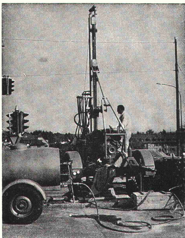
Sondierbohrung Bucheggplatz Zürich
