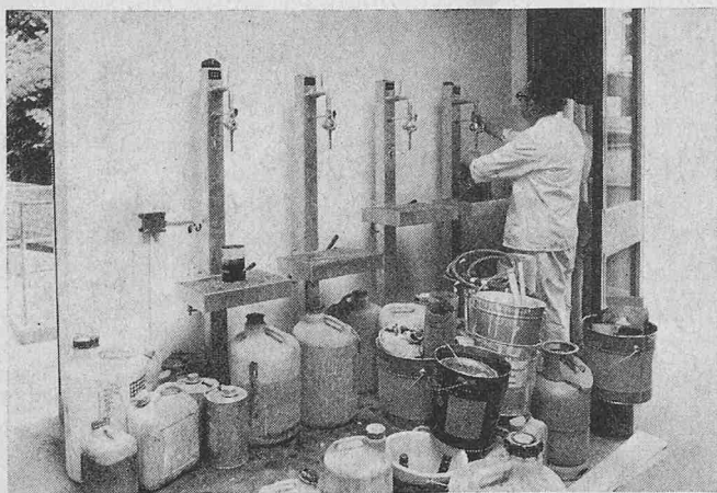
Im Auslieferungsraum befinden sich die vier Zapfstellen für die verschiedenen Lösemittel. Sauber und feuergeschützt wird das flüssige Lagergut durch Motorpumpen aus dem Tank diesen Zapfstellen zugeführt
