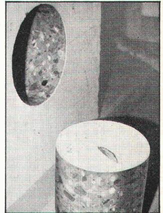
Millimetergenaues Bohren mit Bohrkern. Zuputzarbeit erübrigt sich.
