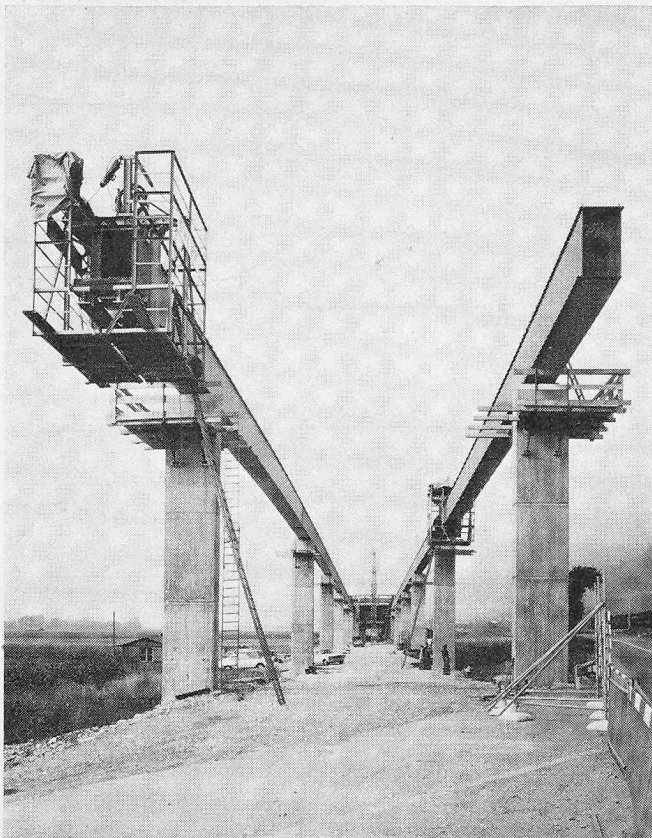
Viaduc du Landeron-Ouest, N. 5 Neuchâtel-Bienne. Passage en biais et en courbe au-dessus de la route cantonale et des voies CFF. Longueur totale de 590 m en 19 travées, dont 12 de 29,0 m, la plus longue ayant 56,0 m et la plus courte 22,0 m. Deux poutres métalliques en caisson de 0,75 m de largeur intérieure par 1,50 m de hauteur, écartées de 10 m, supportent une dalle commune aux deux sens de circulation de l'autoroute. La mise en place des éléments de poutres s'est faite à l'aide d'une grue, travée après travée, et non par lancement comme pour les autres ponts. Dalle en béton coulé sur place sur coffrages mobiles
