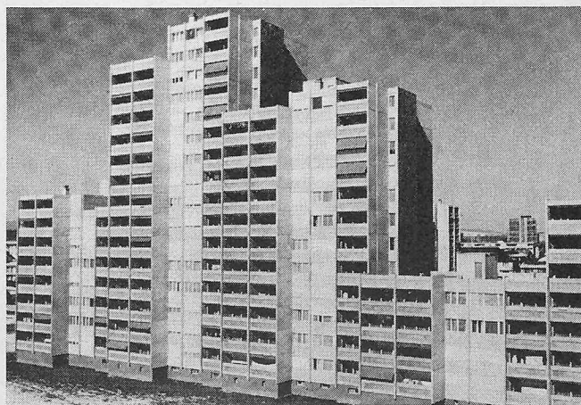
Bild 1. In Grosstafelbauweise vorgefabrizierte Wohnüberbauung Kleefeld-Ost in Bern
