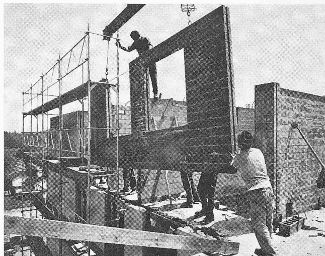
Bild 4. Montage eines Fassadenelementes im 17. Stock und Ansicht der Betonplatten des 16. Stockes
