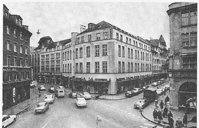
Bild 1. Telefonzentrale Füssli, die «City-Centrale» von Zürich (1925)
