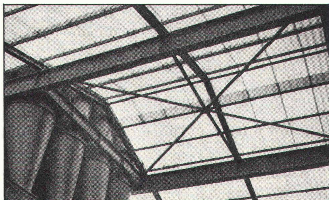
Neomat-Lichtdach auf einer Siloanlage
