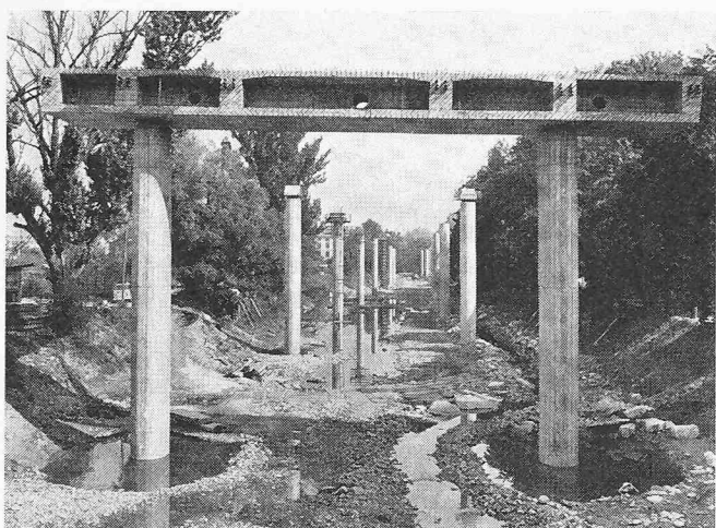
Bild 2. Im Flussbett der Sihl erstellte Hochstrassenpfeiler
