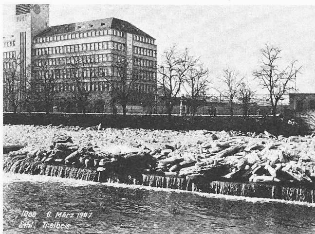
Bild 3. Auftürmung von Treibeis in der Sihl vor der Postbrücke am 6. 3. 1947; aufgestautes Sihlwasser fällt in den Schanzengraben über
