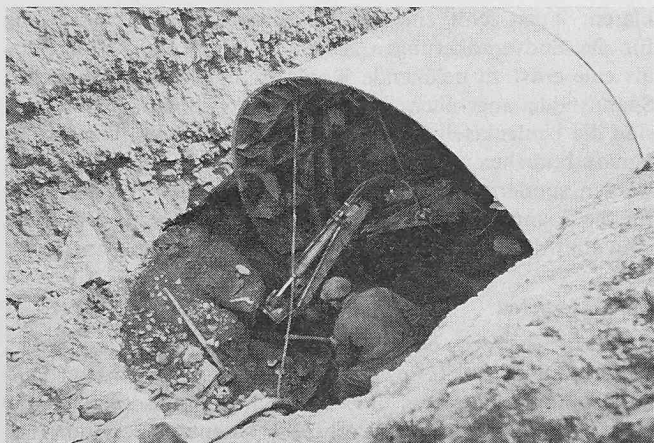
Bild 11. Pressrohrvortrieb «in offener Baugrube». Abbau des Erdmaterials bei der Schneide mit einem im Rohrprofil installierten Bagger
