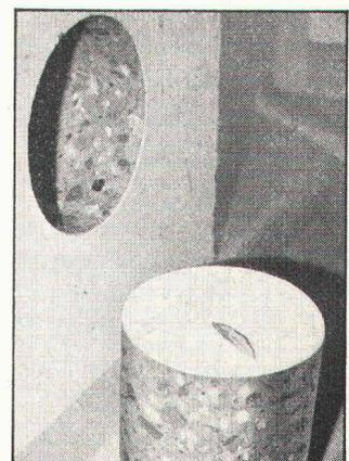
Millimetergenaues Bohrloch mit Bohrkern. Zuputzarbeit erübrigt sich.
