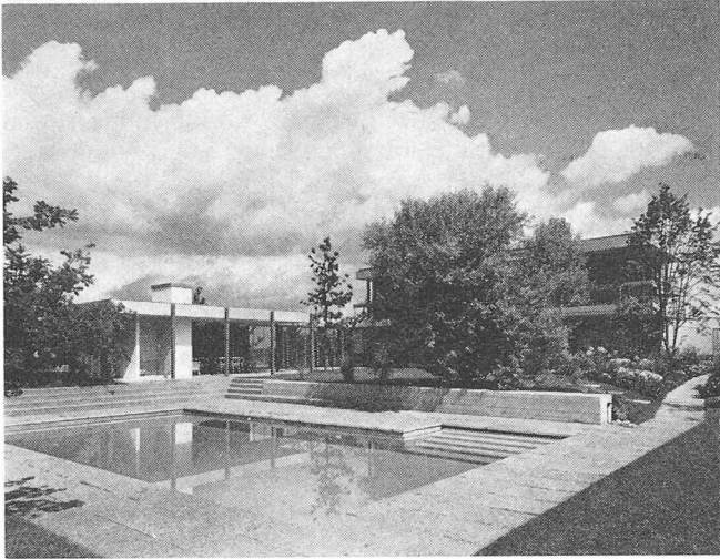
Schwimmbad mit Treppenanlage und Liegemauer gegen den Wohngarten
