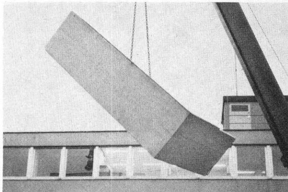
Für einen Erweiterungsbau eines Restaurationsbetriebes musste ein 9 m langes, 2,8 m breites und 46 cm starkes Vordach millimetergenau entfernt werden. bft löste auch dieses Problem spielend. In nur 2 Tagen, ohne Lärm und ohne Staub!
