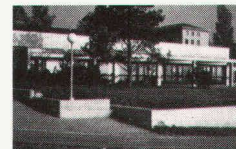
Hôpital de Cery Lausanne
