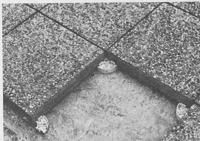
Montage von Bodenplatten auf Kunststoffelementen
