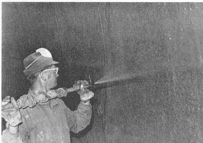
Bild 3. Beschichtungsvorgang mit Kunststoffmörtel auf Ulm
