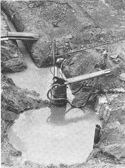
Bild 12. Pumpensumpf mit Steigleitungen. Am Bildrand rechts unten einer der im Text erwähnten Grundwasserbrunnen für das vorzeitige Absenken des Grundwasserspiegels. Der Pumpensumpf liegt in der Formation «Molassesand». Am oberen Bildrand ist der Übergang Kies-Molassesand zu erkennen
