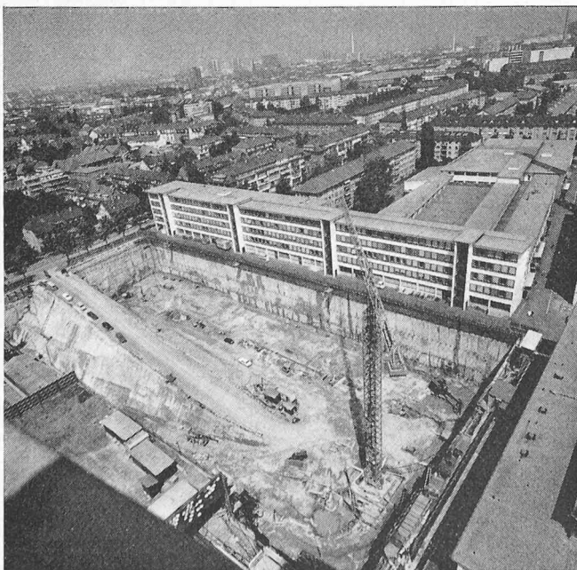
Bild 18. Übersicht der Baugrube im letzten Aushubstadium. Die vierte Ankerlage ist bereits eingebracht. Rampenausfahrt in Richtung Peter-Rot-Strasse. Man beachte die provisorische, ausragende Fahrbahn entlang Bau 49 (Schattenwurf an der Schlitzwand)
