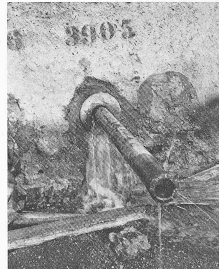
Bild 10. Nachinjektion an einem Bündelanker. Man beachte die Verwendung von gerippten Ankerstählen. 1 Bohrrohr, um die Verankerungslänge zurückgezogen; 2 Ankerstähle; 3 Nachinjektionsrohr, an Injektionsschlauch angeschlossen; 4 Stopfbüchse; 5 aufgegebener Anker (Ankerausfall), definitiv abgedichtet
