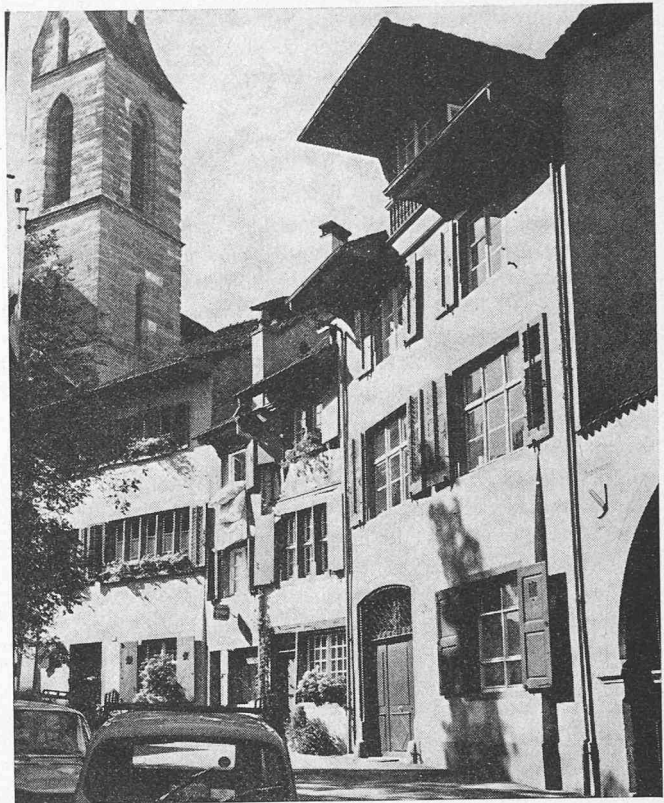
Bild 2. Klimagerechtes Bauen der «Alten»: kompakt, mit minimaler Aussenhaut und ausgewogenem Verhältnis von Loch und Wand
