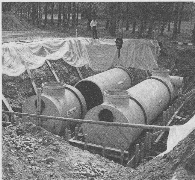
Vorfabrizierte Rückhaltebecken für Lucens VD
