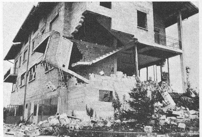
Bild 11 (nach dem 15. Sept.). Rechts: Wohnhaus mit Werkstatt bei Arterga nach erneuter Bebenbeanspruchung. Infolge der weiteren Bebenbelastung stürzte die Stirnwand im Mittelgeschoss ein. Die Tür- und Fensterpfosten der Längswände wurden zermalmt und brachen teilweise ein. Die Schubfestigkeit dieser Betonhohlsteinwände war gering, da der Mörtel in den Lagerfugen keine Verzahnung der übereinanderliegenden Schichten bewirkte
