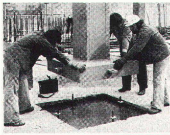
Hohe Gebäude mit schweren Deckennutzlasten verlangen schwere Stützen. Stützen-Montage für das Fernbetriebszentrum der PTT-Betriebe in Zürich-Herdern.
