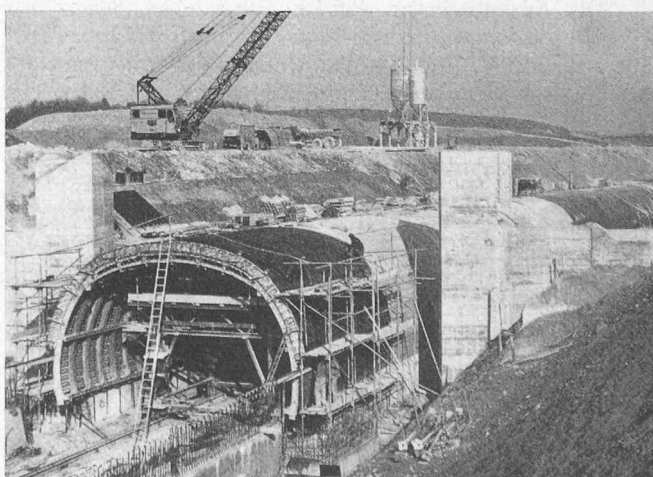
Bild 7. Los 5: Tunnel in geböschter Baugrube mit Düker, Vorfluter Werft III
