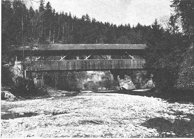
Ruchmühlbrücke vor der Zerstörung
