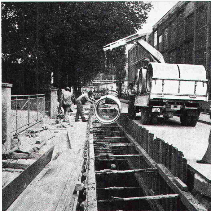
Abladen und Einsetzen von Betonröhren mit einmontierten «BFL-Mastix»-Bändern
