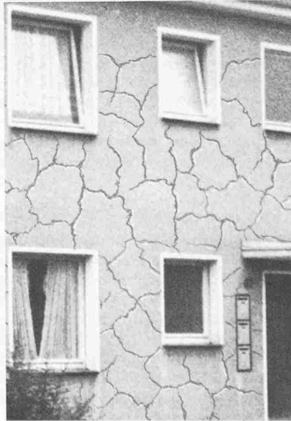
Bild 3. Spannungsrisse
