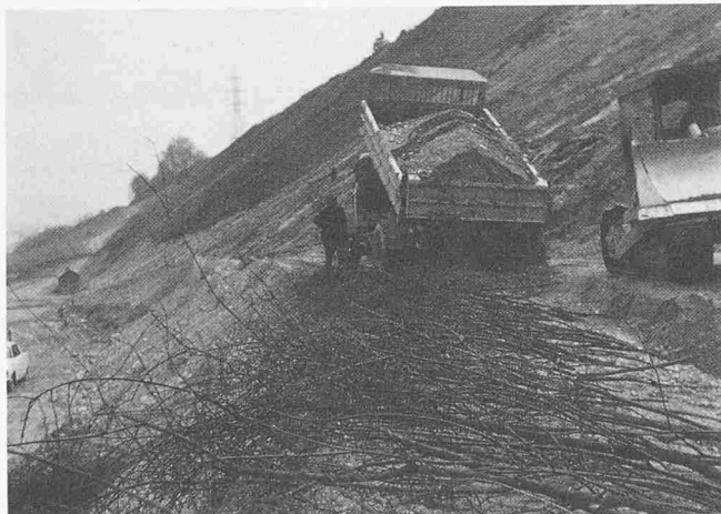
Bild 5. Buschlagenbau während der Schüttung
