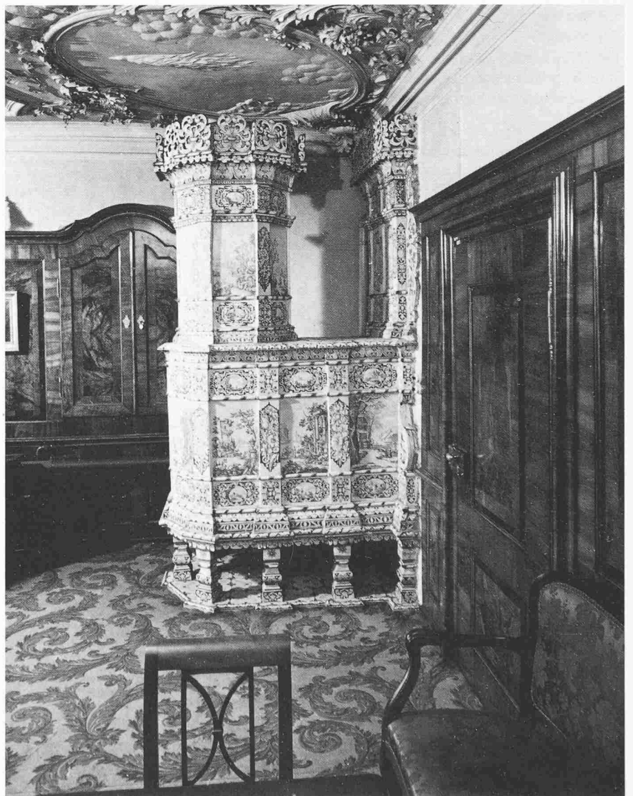
Täferzimmer mit Turmofen im dritten Obergeschoss des «Neuhauses»
