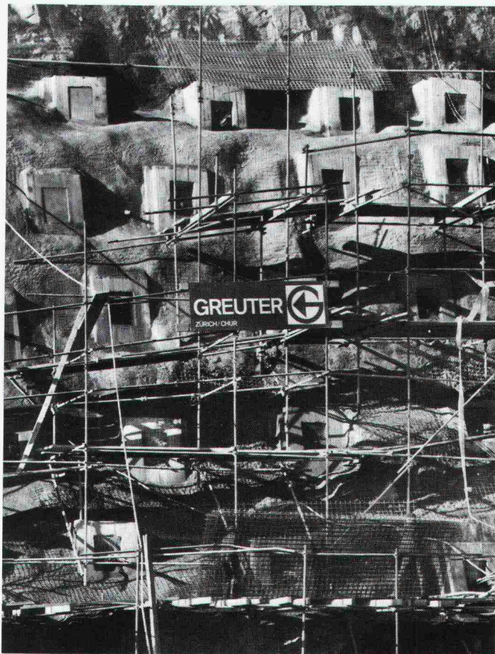
Felssicherung Dangernfluh, N2 (Eptingen)
