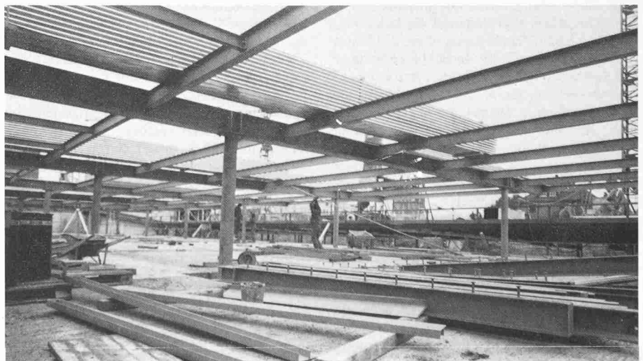
Vollstahlstützen, Haupt- und Sekundärträger, Verbundbleche zum Verlegen bereit
