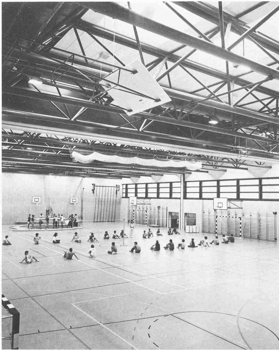
Blick von der Zuschauergalerie in die Sporthalle. Sämtliche Geräte und die Lüftung sind frei sichtbar in die offenen Fachwerkträger integriert
