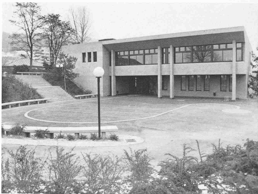
Ansicht von Westen, Pausenplatz
