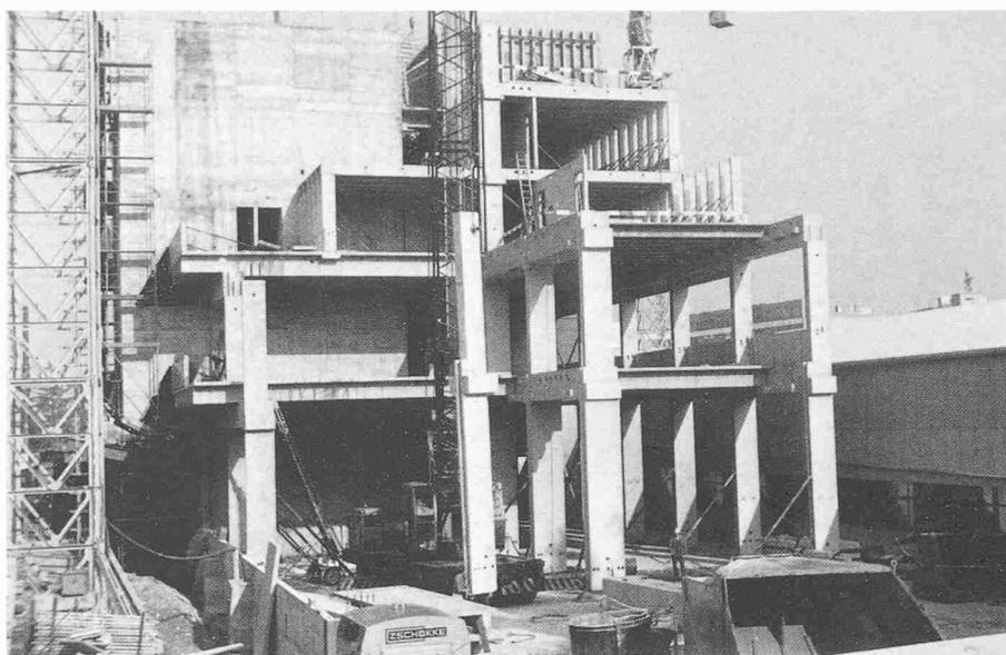
Montage des östlichen Traktes. Auch die Zwischenwände mit den Türzargen sind vorfabriziert
