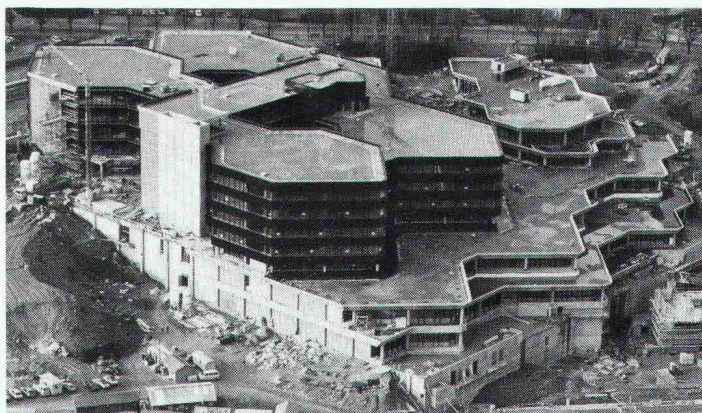
SKA-Neubau Uetlihof Zürich 28'000 m 2 Sarnafil
