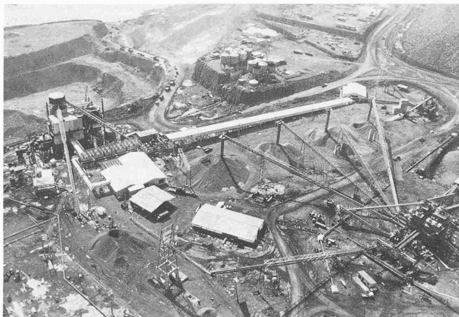
Die Kältezentrale auf dem brasilianischen Ufer mit dem 200 m langen Tunnel zur Vorkühlung des Kieses
