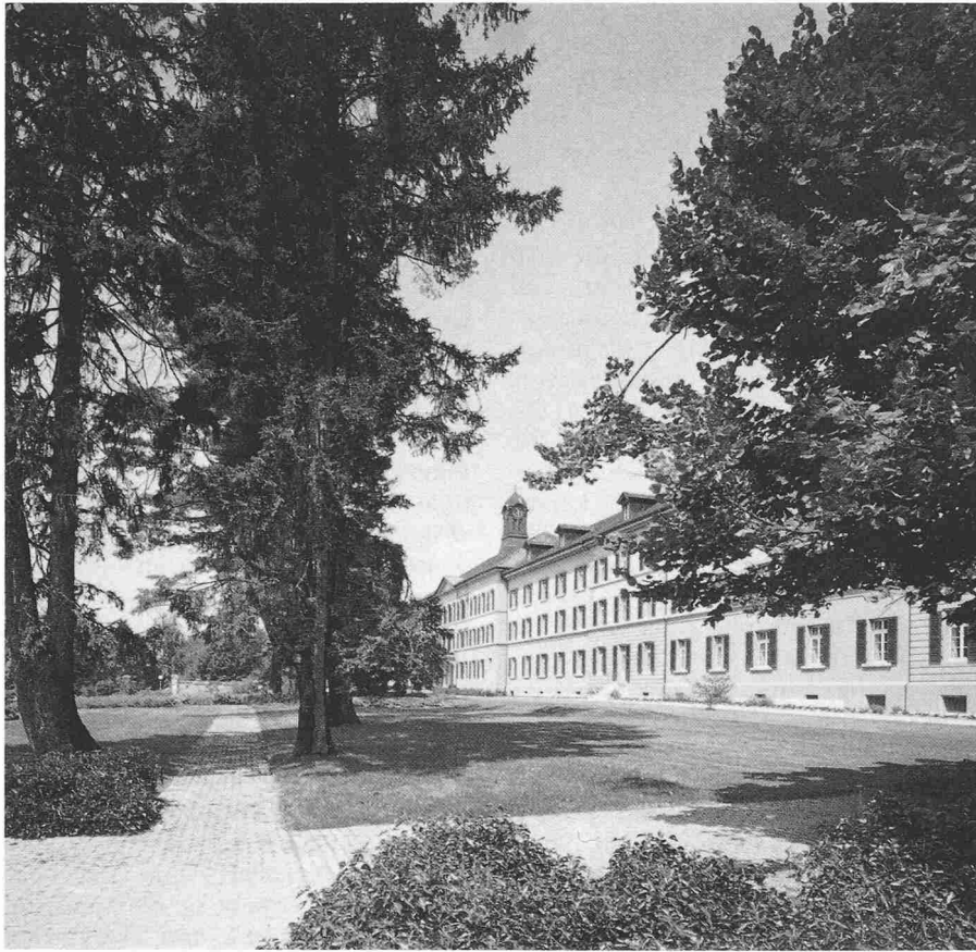
Ausschnitt Südfassade Ostteil
