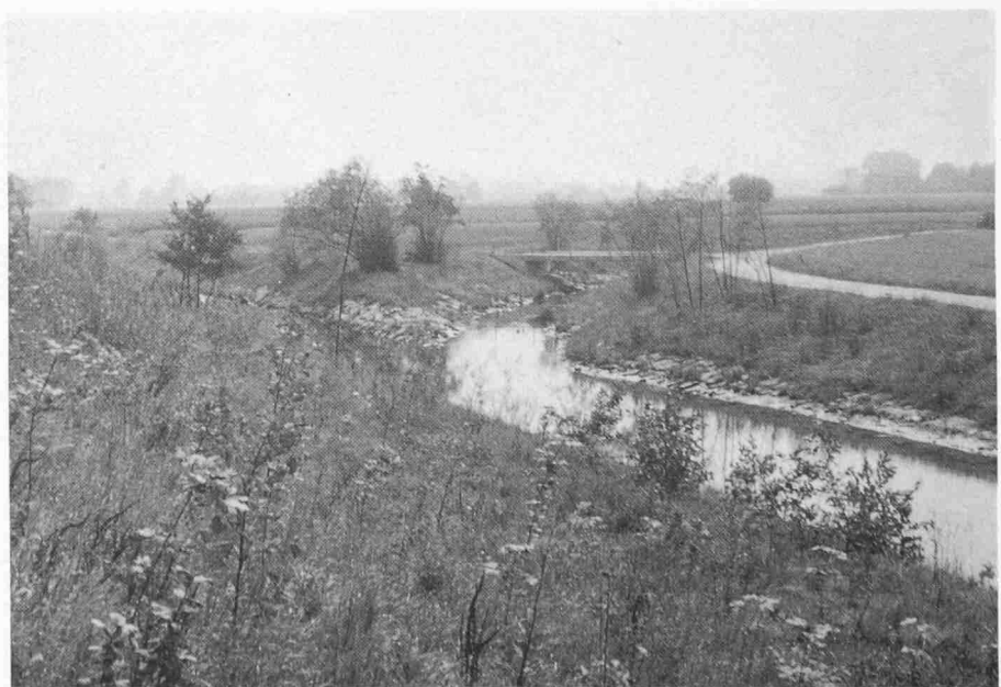
Bild 13. Hauptentwässerungskanäle in Aristau/Merenschwand (Bild: R. Maurer)
