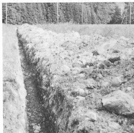
Bild 5. Bodenaufschluss gibt Auskunft über die Art des Auffüllmaterials
