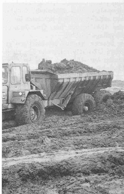
Bild 1. Auffüllarbeiten bei nassem Wetter
