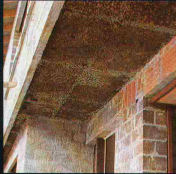
Kork in die Schalung gelegt
