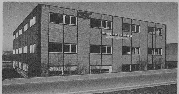
die äusserst attraktive Arcoy-Alufassade und doppelverglaste Fenster mit zweifach gebrochenem Rahmen, um Kältebrücken zu vermeiden. Diese Fassade wurde an Ort und Stelle mit dem Startex-Spritzdämmstoff in 14 cm Dicke nahtlos gefüllt. Das Dach in Stahl-Holz-Konstruktion (siehe Bild) erhielt eine 20 cm starke Isolation mit Star-
