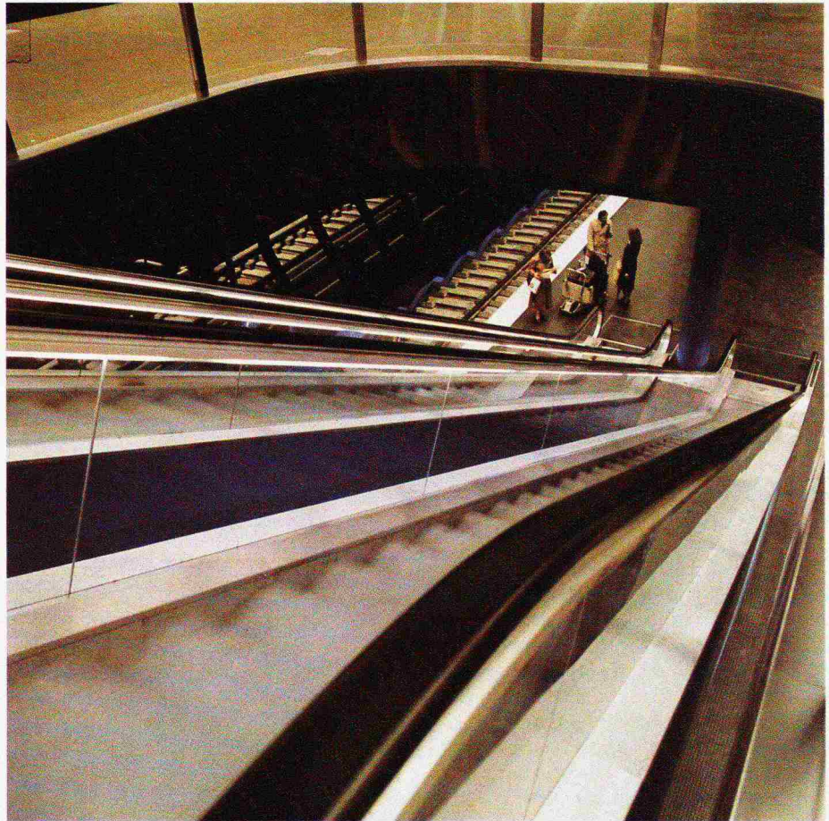
Bild 2. Rolltreppe zwischen Perrongeschoss und Bahnhofhalle
