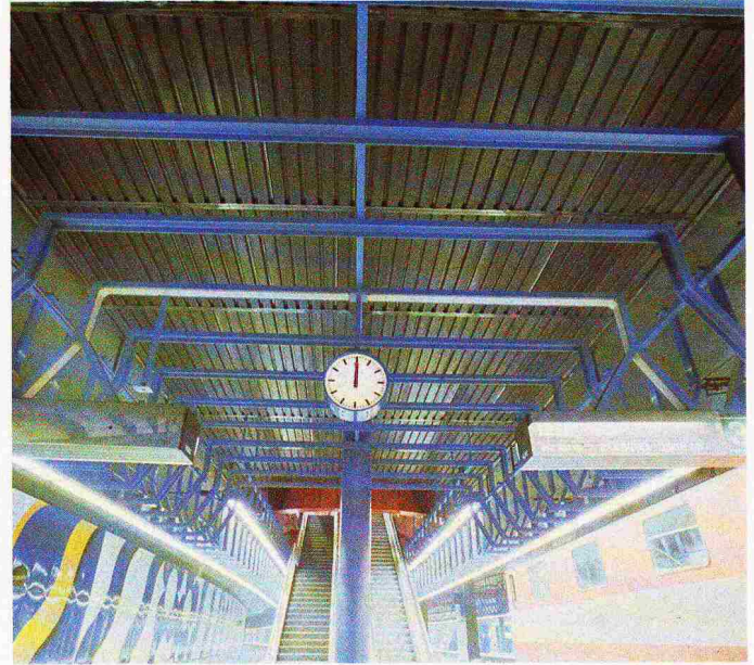
Bild 4. Rippenkonstruktion über dem Perrongeschoss
