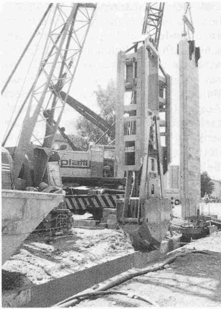
Bild 2. Schlitzaushub und Versetzen eines vorgefertigten Wandelements
